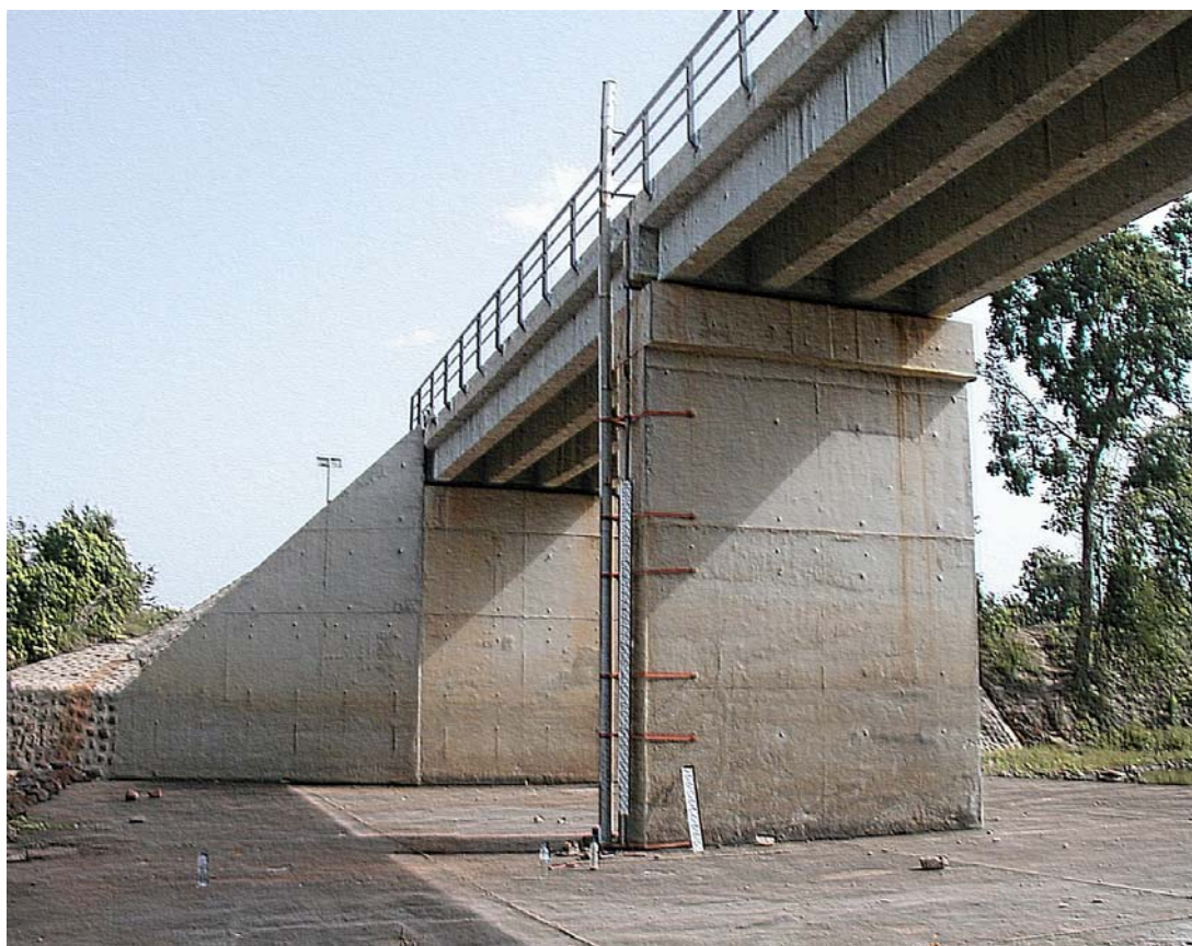
Station sur la T rou   Cote238, vue de l'aval vers l'amont. (rabaissment du z ro de l' chelle par les travaux du 24 mai 2005)
